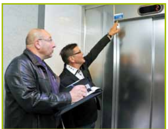
Eugène Rossi et Jean-Claude Monottoli en tournée de vérification des liaisons piétonnes mécanisées
