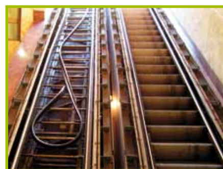
Mise en place d'un escalator
